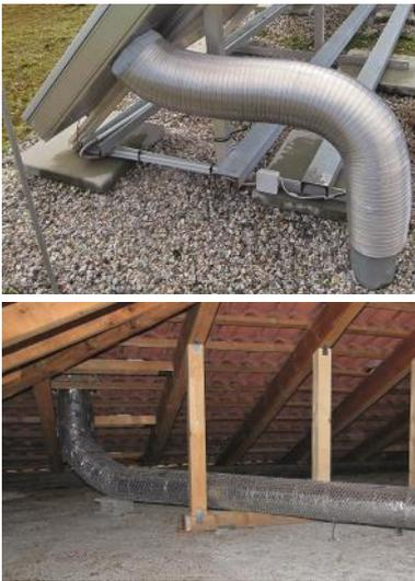
Innen wird die warme Luft möglichst direkt in den Raum eingeblasen. Um an eine geeignete Stelle zu gelangen, können 3 – 5 m Schlauchleitung verlegt werden.
